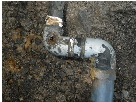
給水管交換完了
