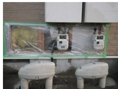
漏水によって破損した外壁補修
