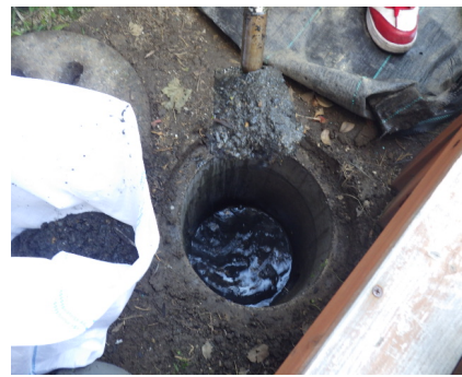
給水管カバー補修
